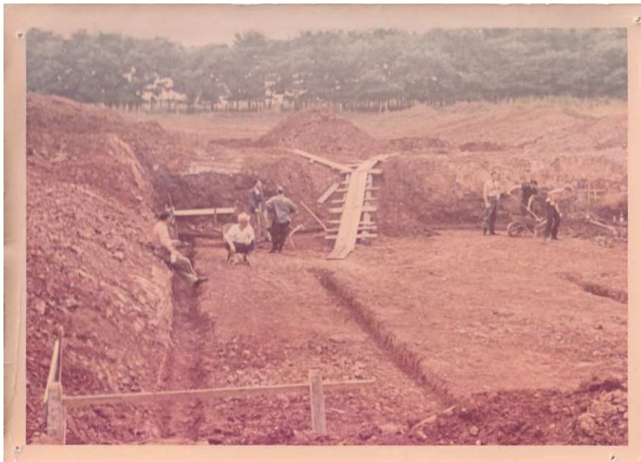
Ausheben der Baugrube 1969
