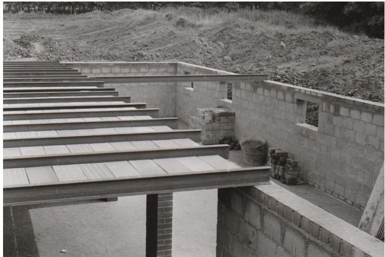
Einbringen der Kellerdecke
